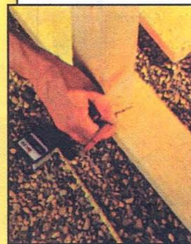
Итак, стойки (опоры) делают из досок 32х100 мм и брусков 45х95 мм. Всего понадобится 10 досок D, 5 брусков G с выборкой для продольной балки и 4 доски C с выборкой для лаг, 6 досок для промежуточных стоек F и E и один брусок H для опоры средней продольной балки.
