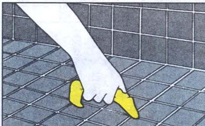
Установив на столешнице все панели, заполняют швы двухкомпонентным эпоксидным составом. Готовят эпоксидную затирку небольшими порциями. Излишки эпоксидки сразу удаляют.
