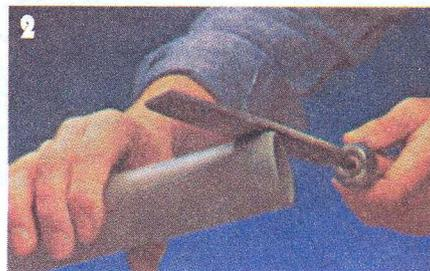
2 Поверхность трубы от торца до метки зачищают напильником.
