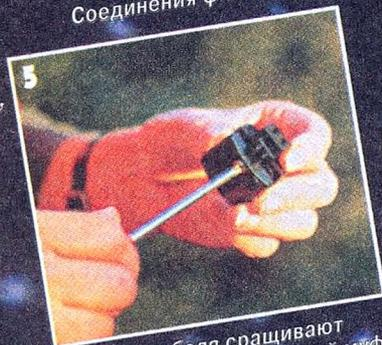
5 Отрезки кабеля сращивают с помощью соединительной муфты, которую можно установить в любом месте. Винт муфты следует открутить настолько...
