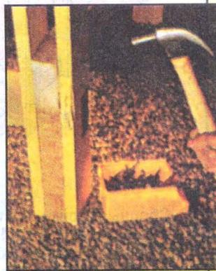
Итак, после того как бетонный фундамент застыл, продольные балки крепят в выборках опор гвоздями, забивая их наклонно. Таким же образом крепят к стойкам лаги.
