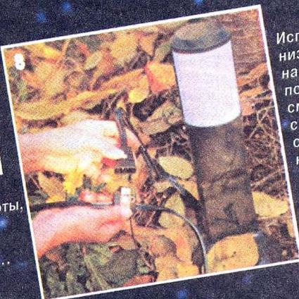
8 Использование низкого (12 В) напряжения позволяет не только смонтировать систему освещения самому, но и делает эксплуатацию ее безопасной для человека и животных.
