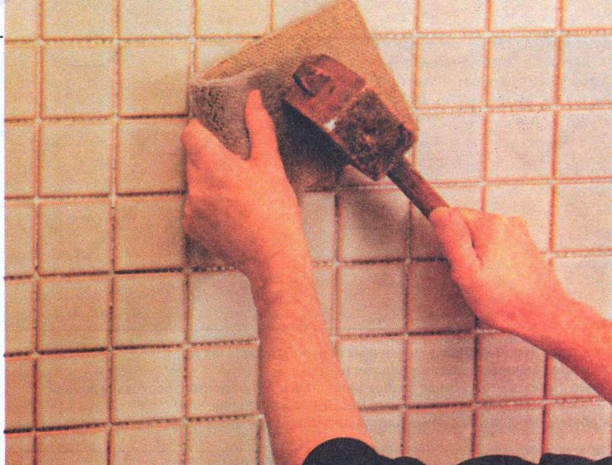
Установив четыре панели, обстукивают их киянкой через кусок старого ковра или деревянный брусок, чтобы сетка-подложка равномерно прижалась к стене, а каждая плитка плотно «села» в клеюю подушку.
