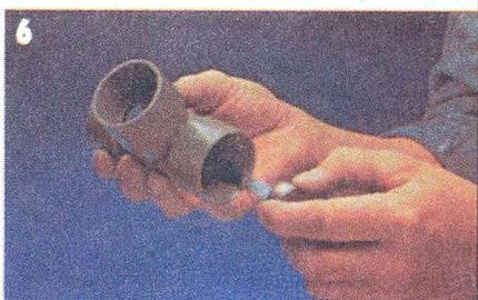
6 На внутреннюю поверхность фасонной части клей наносят ровными мазками в направлении изнутри к краю.
